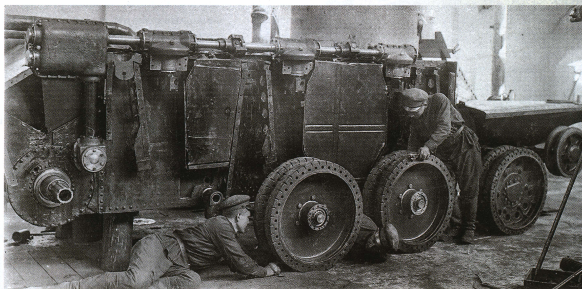
Сборка первого образца БТ-ИС (на базе БТ-2) на заводе № 48, 1935 год. Обратите внимание на карданные валы приводов колесного хода в верхней части корпуса.
